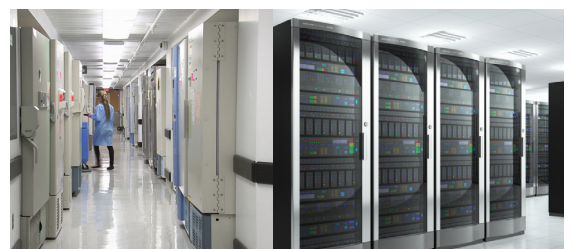
Notversorgung bei Stromausfall
